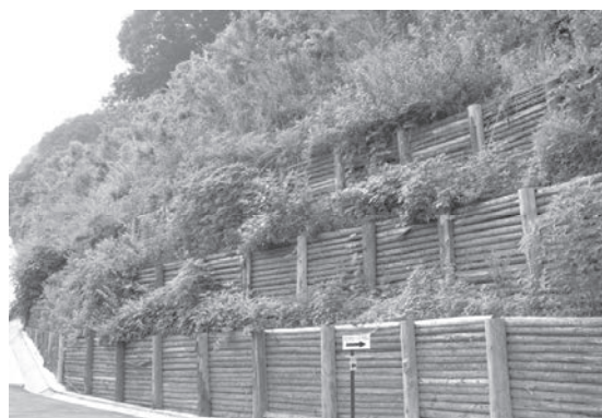
図一 45度の斜面に適用した全天候フォレストベンチ工法の基本的形状
