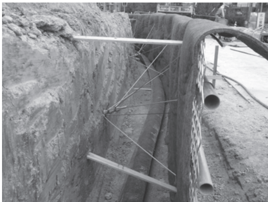
写真—1 直立受圧板と段切り地盤と有孔管、アンカーとワイヤーの連結状況
