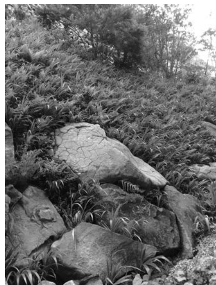
写真—5 法枠緑化完成後
