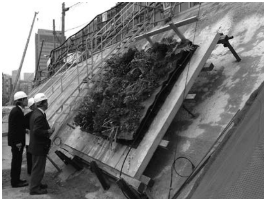
写真一6 法枠緑化モックアップ
