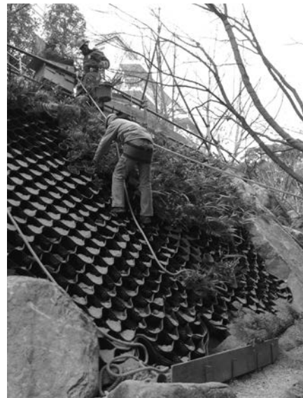
写真—4 法枠緑化施工中
