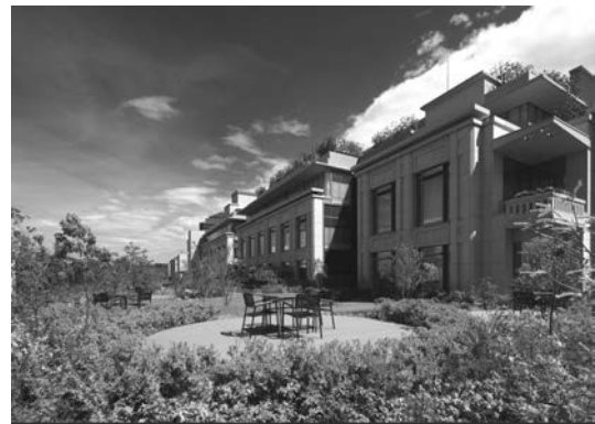
写真一8 Aブロック7F屋上庭園
