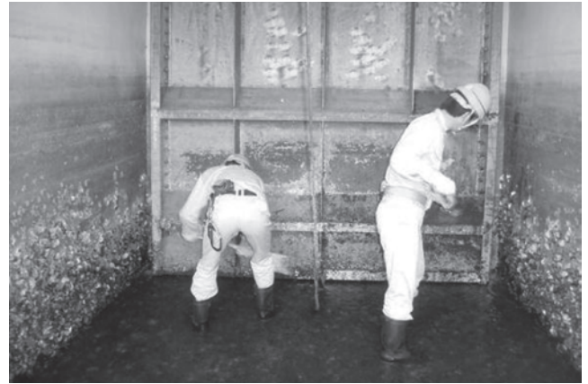
写真—2 付着した貝類の除去作業状況
