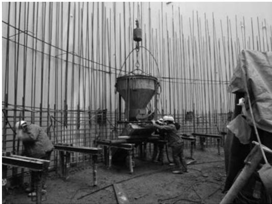
写真一5 コンクリートホッパー打設状況
