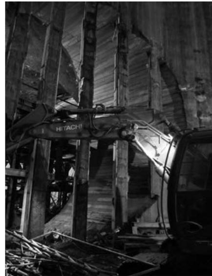
写真一9 仮支柱撤去状況
