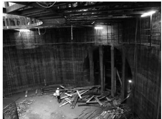
写真一8 坑内換気連絡坑開口部
