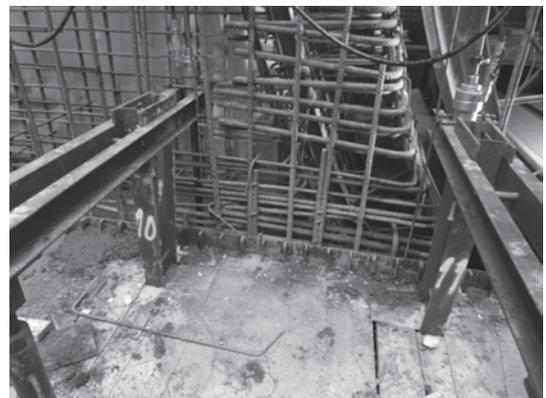
写真-2 ヨーク材と鉄筋状況
