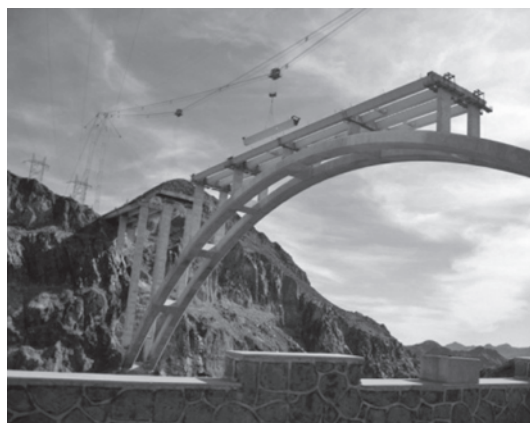
写真—5 鋼製桁運搬架設
