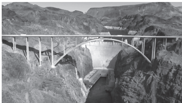
写真—13 完成写真
