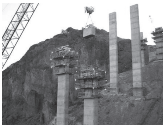
写真—4 橋脚セグメント架設
