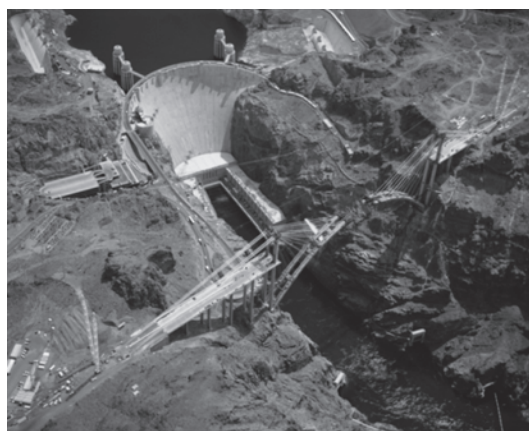
写真—1 フーバーダムと施工中の本橋
