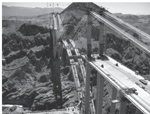
写真—7 ピロン柱と斜吊りケーブル
