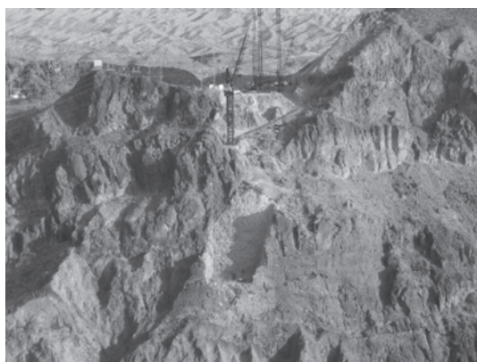
写真—2 アリゾナ側アプローチ掘削
