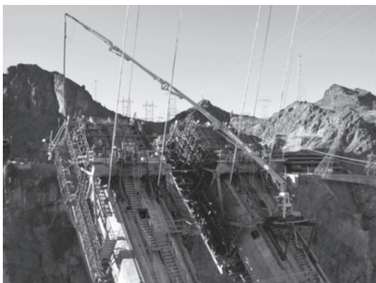
写真—11 コンクリート打設用ブーム
