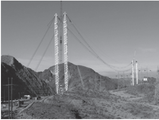
写真一 8 ケーブルクレーン全容
