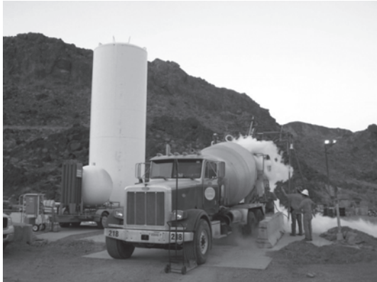
写真—10 液体窒素による生コン冷却
