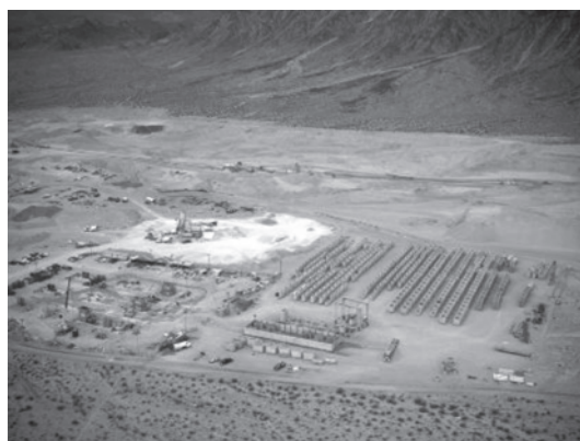
写真—3 プレキャストヤード全景
