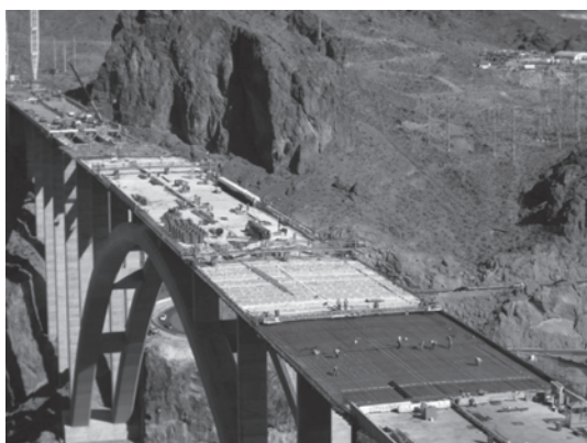
写真—6 床版作業全景
