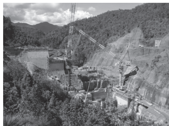
写真—5 堤体打設状況全景
