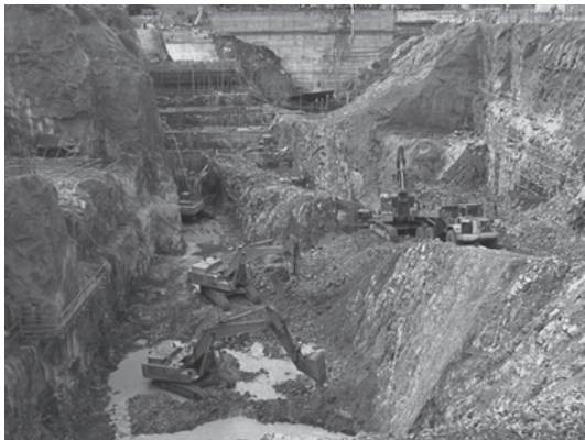
写真—2 転流後 河床掘削状況
