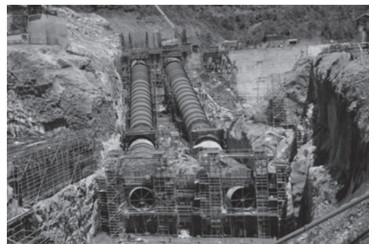
写真—4 導水鉄管据付状況全景
