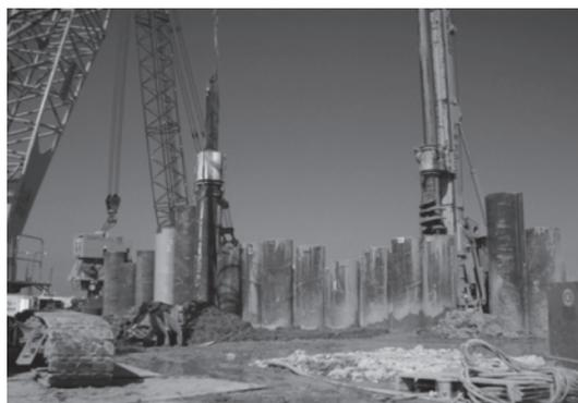
写真-5 中掘りおよび油圧ハンマー
