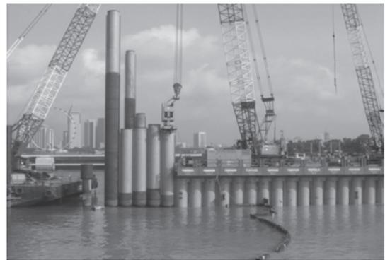
写真-2 海上部の鋼管矢板重防食
