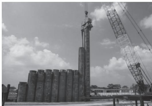
写真-4 鋼管矢板打設 (バイプロハンマー)
