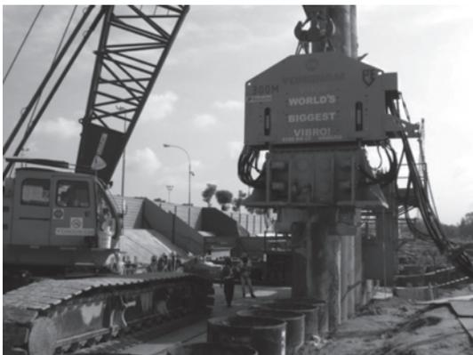
写真—6 鋼管矢板引き抜き状況
