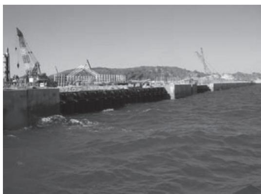
写真-18 岸壁コーピング施工中
