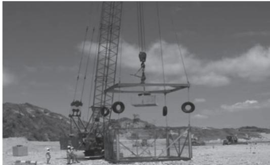
写真-14 埋め立て地、イルミナイト集積倉庫基礎部の捨石のダイナミックコンパクション
