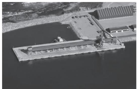
写真-5 完成した岸壁。手前が-17.4m 第1岸壁、奥が-8.0mの第2岸壁
