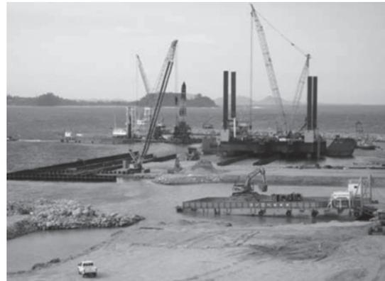
写真-15 工事最盛期の岸壁施工状況。手前から、浚渫土埋立、中程左で鋼管矢板裏込め、右で SEP による鋼管矢板・杭打ち込み、その後方で浚渫、さらに奥では防波堤先端部投入
