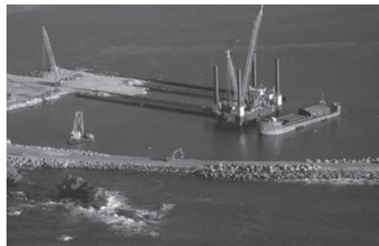
写真-16 SEP による鋼管矢板・杭打設状況
