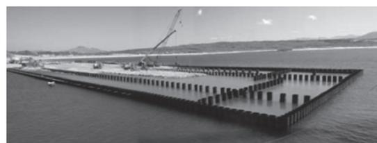
写真-17 鋼管矢板閉合。左奥ではタイロッドと裏込め施工中
