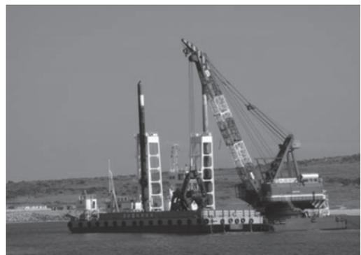
写真—13 25 m<sup>3</sup> 級浚渫船, 11 m<sup>3</sup> 重バケットによる浚渫状況
