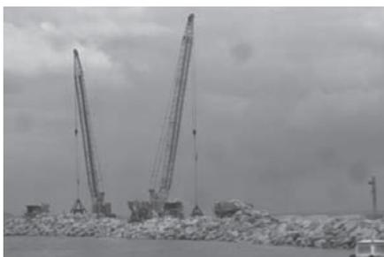
写真—9 280 t クレーン 2 台による防波堤暫定断面までの石材投入状況
