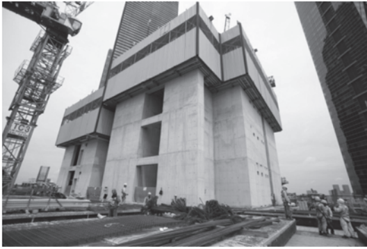
写真-2 オートクライミングフォーム写真(仰視)
