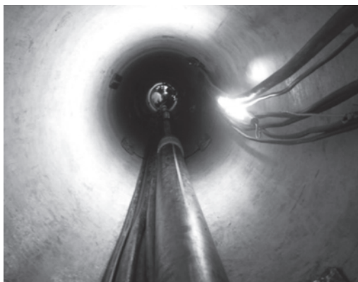
写真-13 坑内状況
