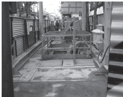
写真-15 立坑上プラント設備
