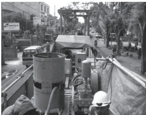
写真-8 立坑上プラント設備
