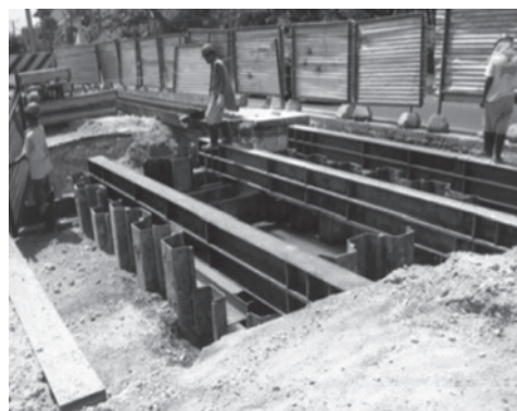
写真-9 立坑築造 (鋼矢板+路面覆工)
