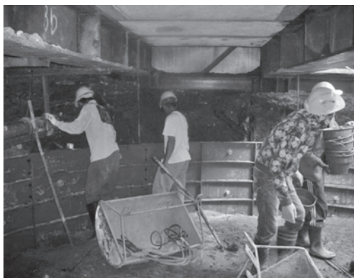
写真-12 立坑築造 (ライナープレート+路面覆工)
