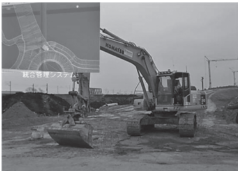
図一1 調査したドイツの施工現場
