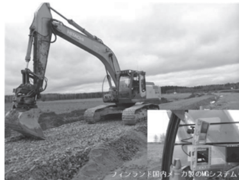
図一2 調査したフィンランドの施工現場
