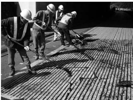
写真—3 凍結抑制材の充填
