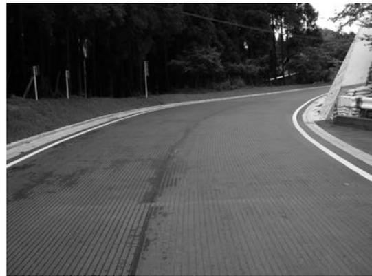
写真-6 カラー化した事例（右半分車線を赤ゴムで施工）
