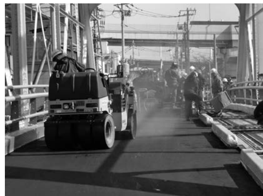
写真一4 コンバインドローラによる転圧（鋼床版での適用例）
