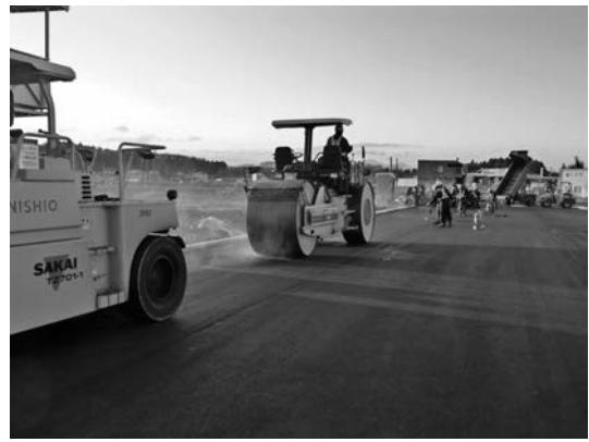
写真—6 マカダム・タイヤローラによる転圧（表層での適用例）
