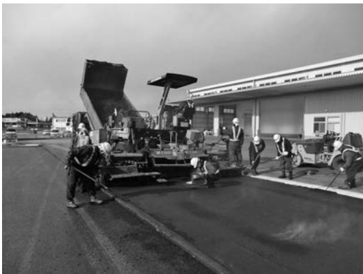
写真—5 AFによる敷均し（表層での適用例）
