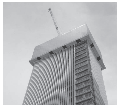
図-1 超高層解体工法イメージ
