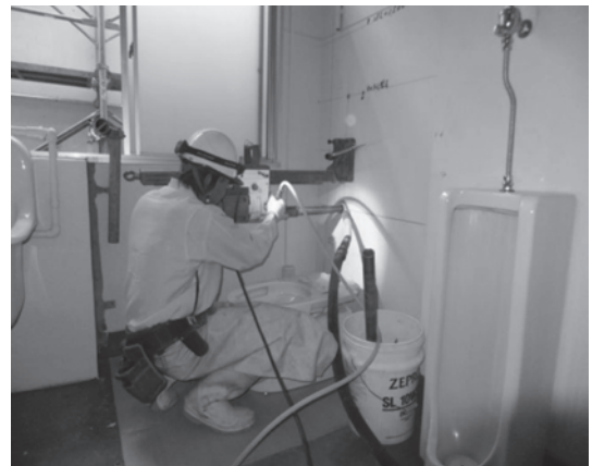
写真一2 柱のコア抜き
