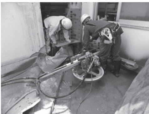
写真-4 左：柱の切断状況，右：柱の切断後の状況
