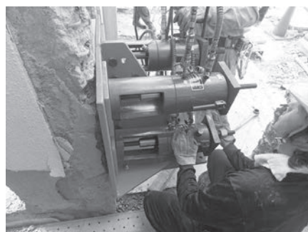
写真一3 左：柱以外の躯体切断状況，中：PC 鋼棒緊張，右：ブラケット取り付け状況
