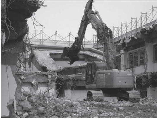
写真—6 階上解体の状況
