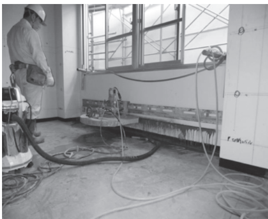
写真一1 ウォールソーによる壁の切断
