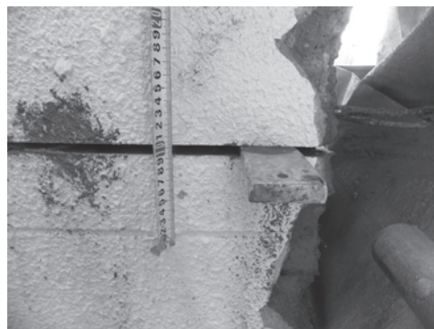
写真-4 左：柱の切断状況，右：柱の切断後の状況
