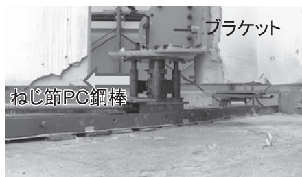
d スライドの仕組み
