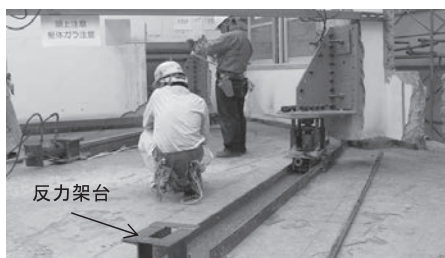
a 反力架台の設置
