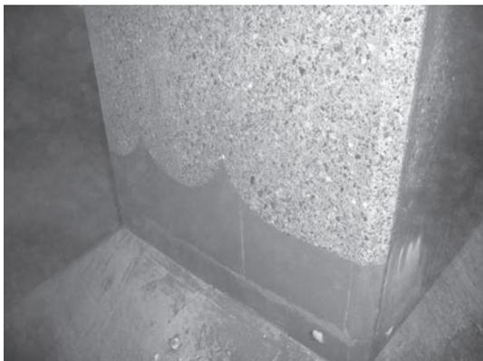
写真一七 WJ 表面処理機による処理面
