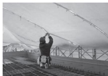
写真二 養生シート設置状況
