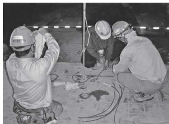
写真-4 基礎梁への装薬状況
