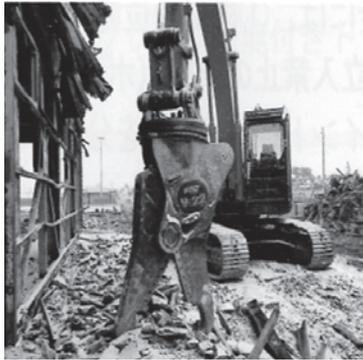
写真一 鉄骨切断機 (日立建機(株)製建設業労働災害防止協会提供)
