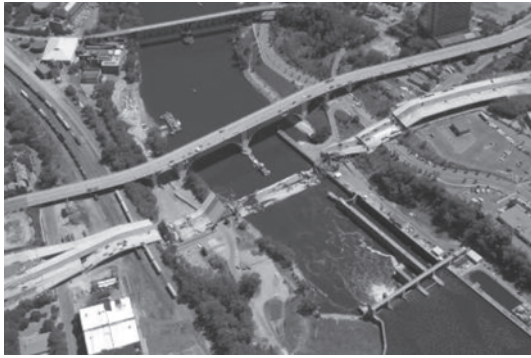
写真一六 崩落後のI-35W橋の全景（出典 MN/DOT8）
