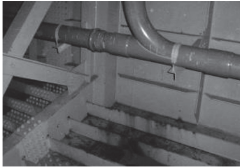
写真一 箱桁内部への漏水・滞水の例
