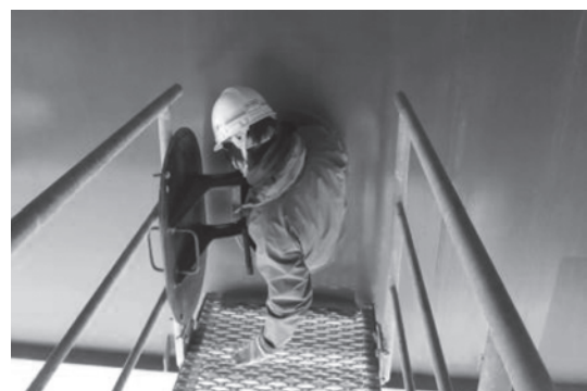
写真一3 点検や資機材の搬入が困難な例
