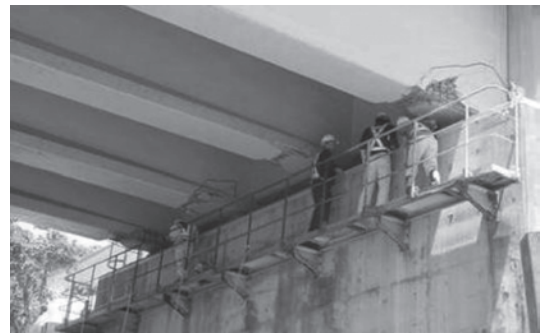
写真一1 検査路による近接点検
