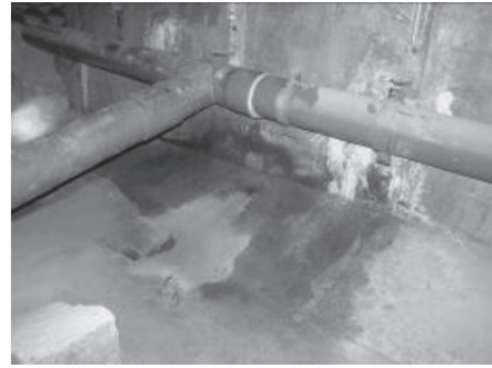
写真一 箱桁内部への漏水・滞水の例
