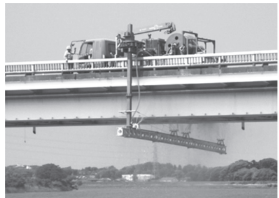
写真四 橋梁洗浄の状況
