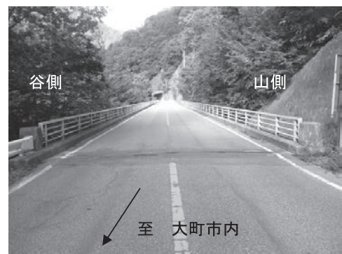
写真-1 橋梁全景
