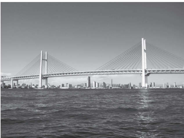
写真—1 横浜ベイブリッジ
