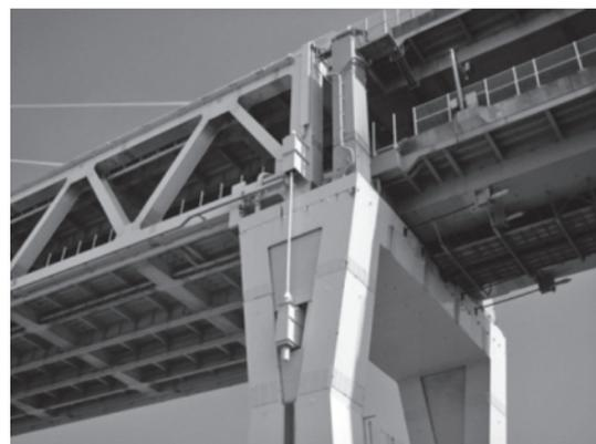
写真—6 端橋脚部の負反力ケーブル支承
