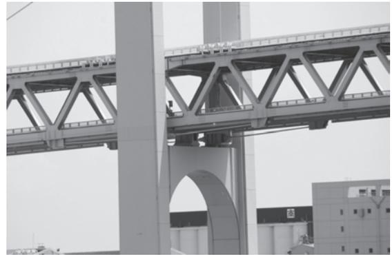
写真—2 塔部の橋軸方向変位制御装置
