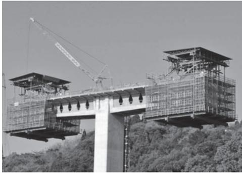
写真一3 張出し施工状況
