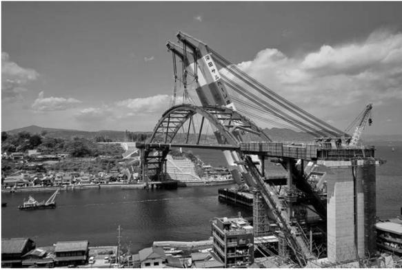
写真-9 荷重解放完了
