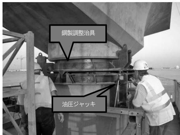
写真—6 特製治具によるPCa型枠の調整状況
