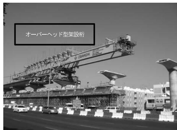
写真一八 架設桁によるスパンバイスパン架設
