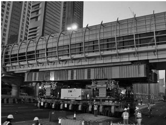
写真一11 歩道橋の運搬・架設状況
