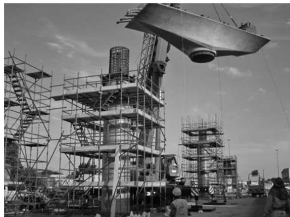
写真—5 PCa型枠 吊込み状況
