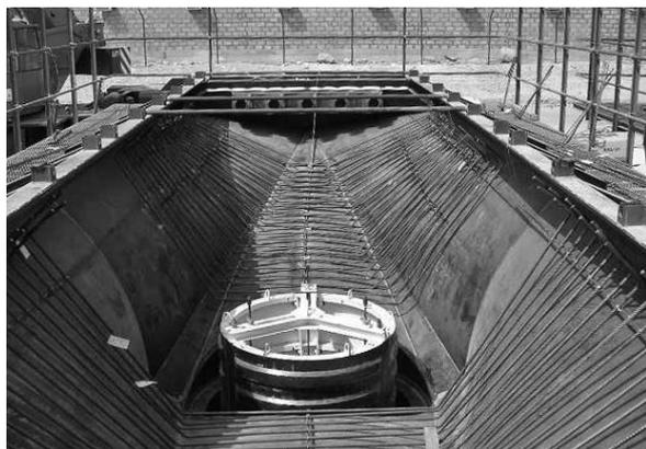
写真—4 PCa型枠製作状況
