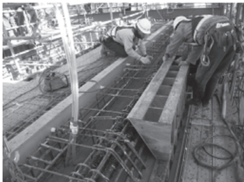
写真-4 ハンチ型枠の設置
