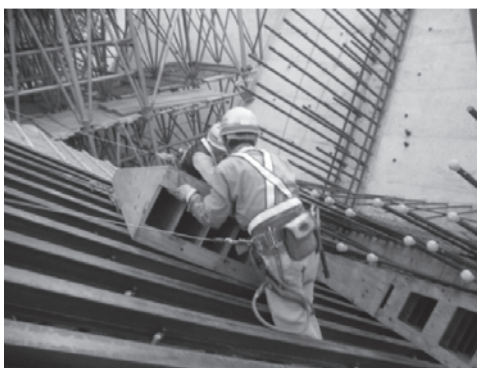
写真—1 底版型枠設置状況
