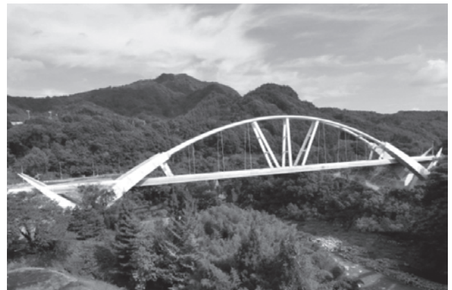
写真-5 第三吾妻川橋りょうの完成
