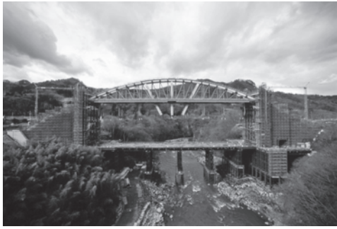
写真一三 第2回リフトアップ状況
