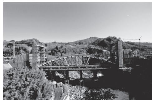
写真—2 第1回リフトアップ状況
