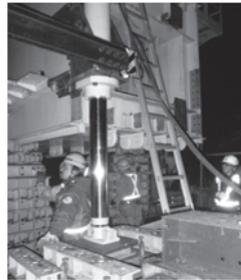
写真— 13 走行ガーダー後端のたわみ出しジャッキ
