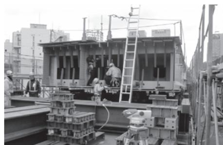
写真-2 鋼桁Gd1の組立状況
