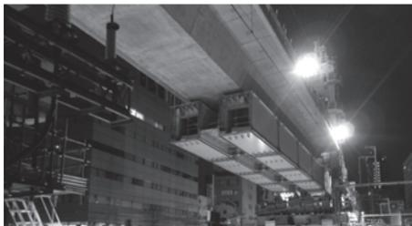
写真一五 走行ガーダーの先送り (Cbp17 架設時)
