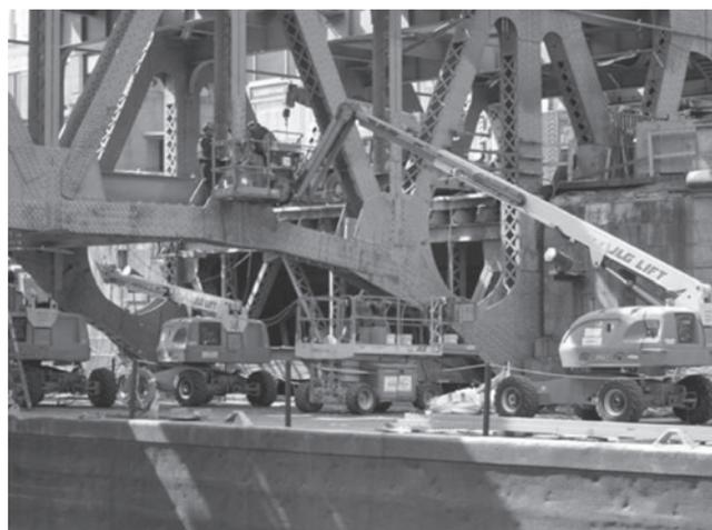
写真-11 シカゴ川に架かる鉄橋補修工事中の高所作業車群
