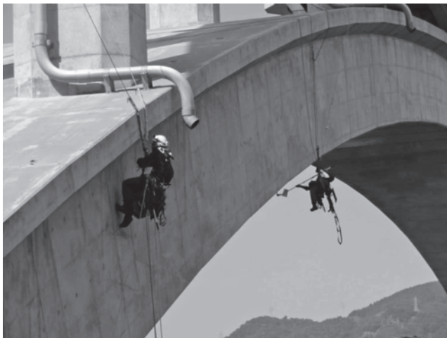
庵谷町長大橋(北陸地方整備局2012.9) 図一5 橋梁の点検作業の実態(事例)
