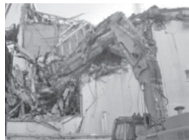
写真—6 次世代無人化施工システム（鹿島建設株式会社，株式会社熊谷組）
