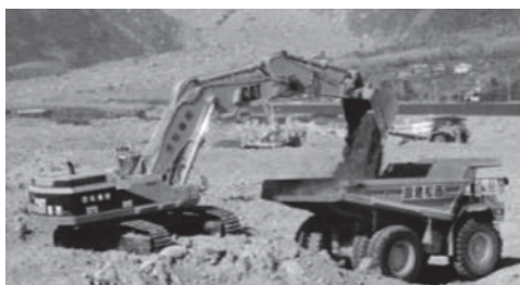
写真1 雲仙試験フィールド施工状況
