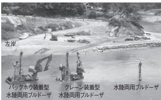
写真—6 落橋回収状況
