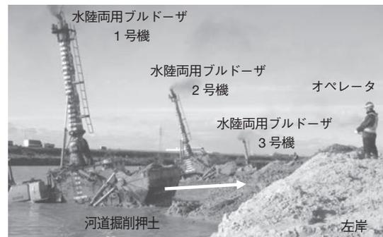
写真-4 庄内川河道掘削状況
