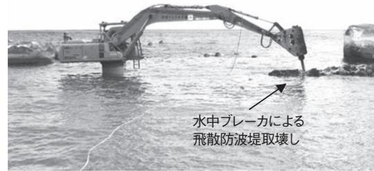
写真-9 コンクリート破碎状況 (水陸両用バックホウ)
