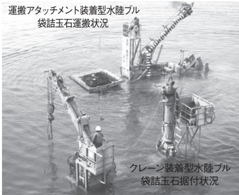
写真-7 袋詰玉石運搬据付状況
