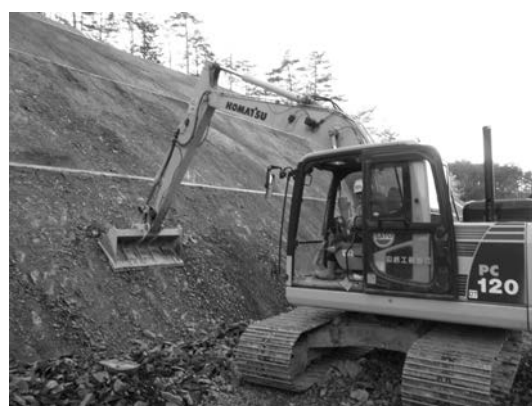
写真—10 2D-MGシステムを用いての法面整形作業
