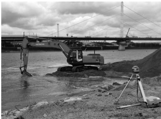
写真—12 河床整備にレーザ基準システムを活用
