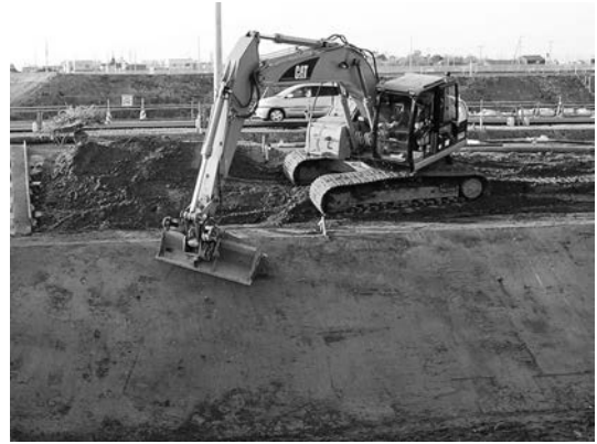
写真—13 スイングバケット機構を活用した法面整形作業
