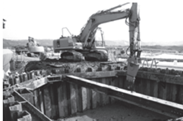
写真—7 切梁直下の斜め施工状況
