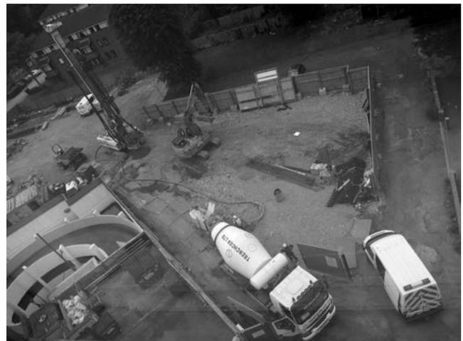
写真—2 Gunnersbury 駅近くの工事現場で稼働中の建設機械群（コンバクトダンパ、杭打ち機、油圧ショベル、トラックミキサ）
