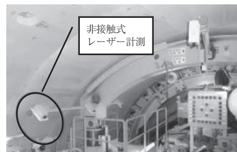
写真-1 セグメント真円度計測システム
