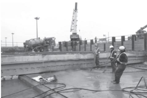
写真一5 砂型枠の撤去状況
