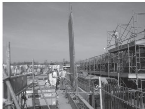
写真一4 鋼製パネル型枠の撤去状況
