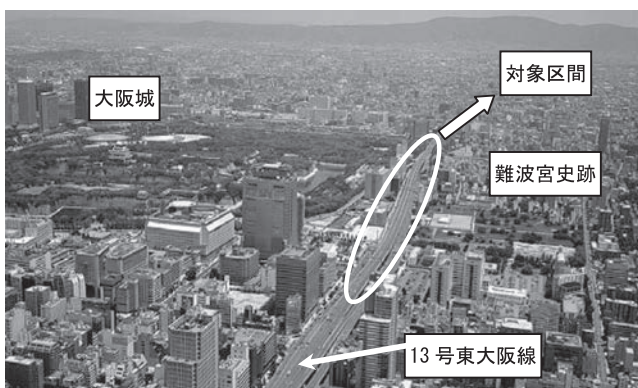
写真一 1 上空写真
