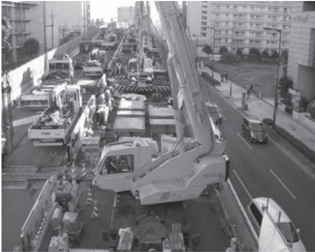
写真—9 クレーン配置状況
