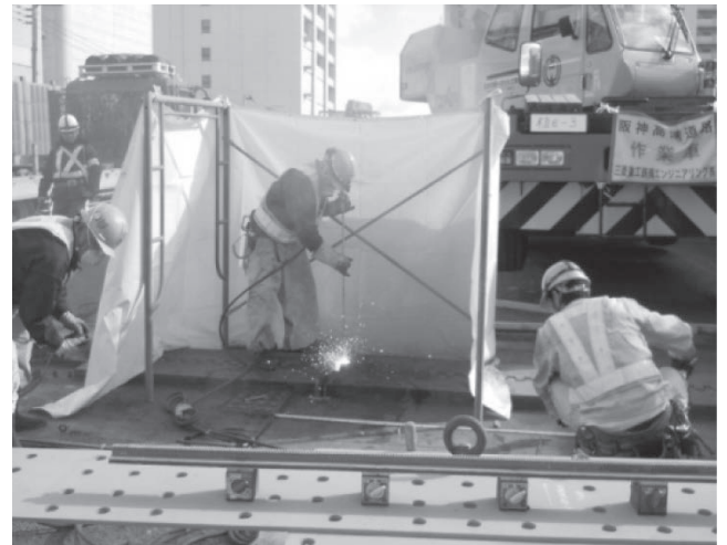
写真一八 伸縮装置切断状況(シャープランス)
