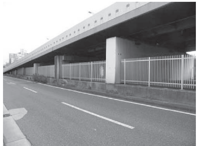
写真-4 対象橋梁外観(法円坂区間)
