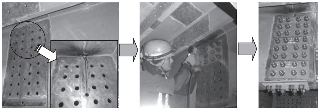
写真—6 主桁ウェブ切断状況
