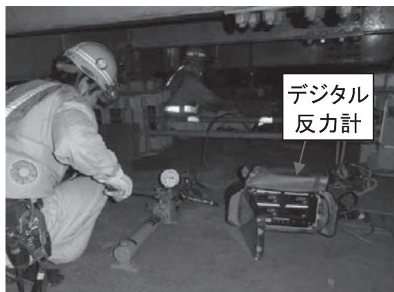
写真—5 ジャッキアップ状況
