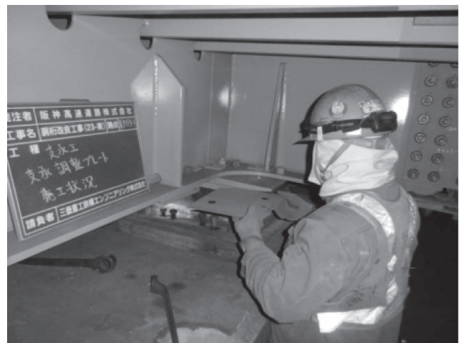
写真—11 調整プレート挿入状況
