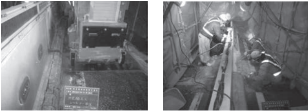
写真一七 中央分離帯地覆撤去状況
