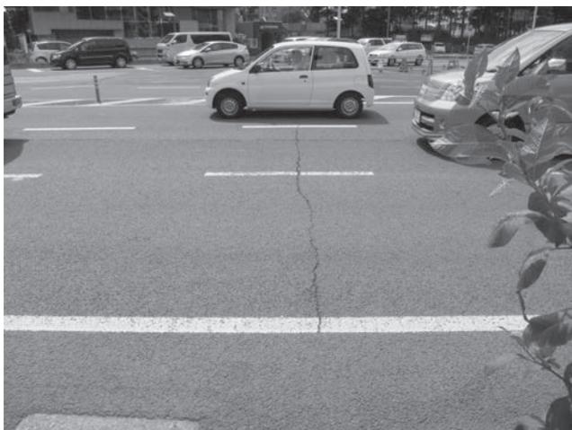
写真-2 傷んだ道路（路面に発生したクラック）
