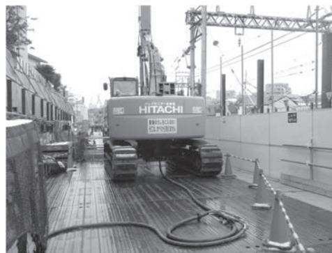
写真—4 電動クラム配線状況
