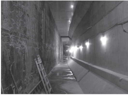
写真一六 (軌道階部 撤去前)
