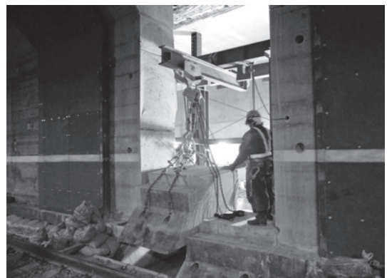
写真一4 最下段ブロック吊り上げ状況
