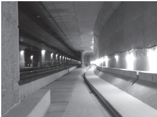
写真一七 (軌道階部 撤去完了後)
