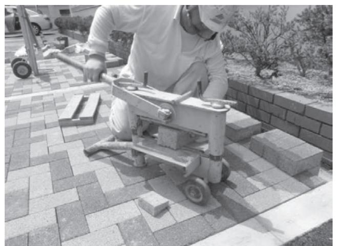
写真一四 C-WRILB をカッターで切断
