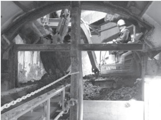
写真一八 到達立坑路下掘削
