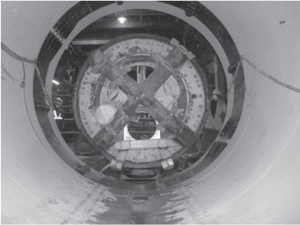
写真一七 内殻引戻し完了
