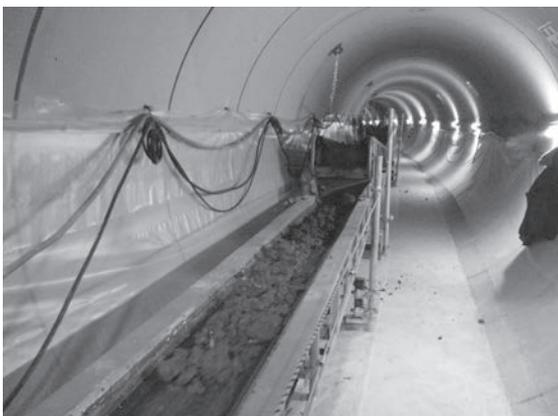
写真一九 掘削土砂搬送
