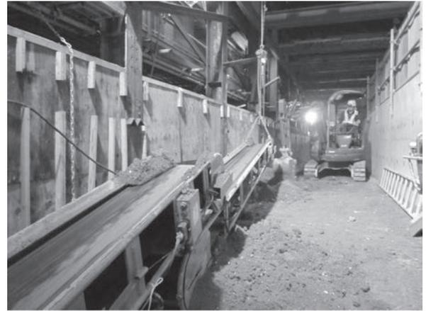
写真一〇 路下ヤード埋戻し状況
