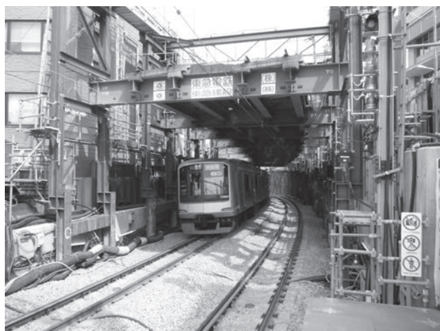
写真—3 地下化切替後
