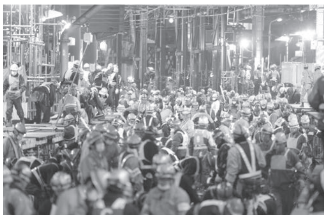
写真—2 地下化切替状況
