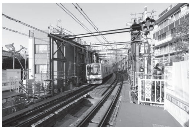
写真—1 地下化切替前
