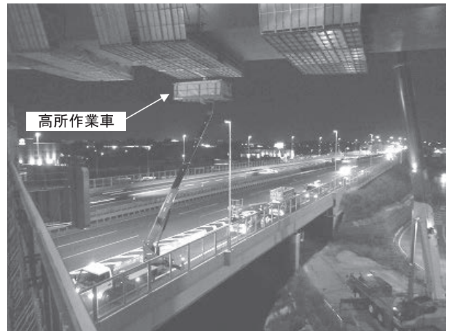
写真—6 高所作業車による防護
