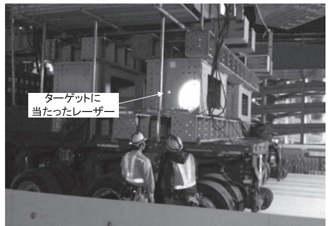
写真-4 レーザーによる確認
