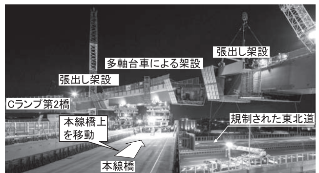
写真一1 多軸台車による一括架設
