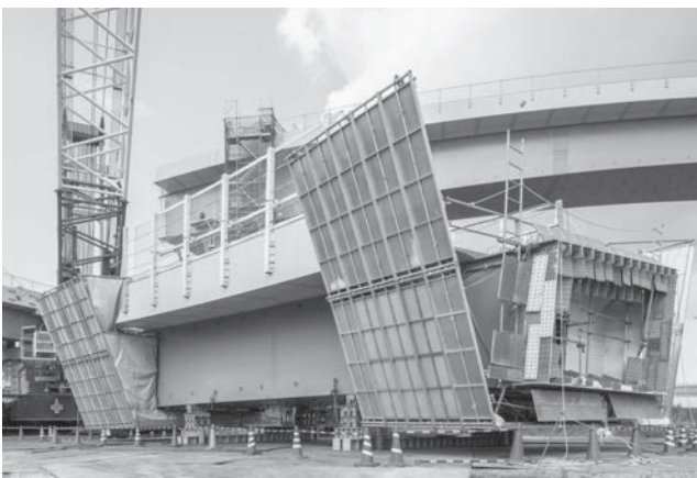
写真—5 先行設置された足場
