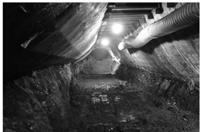
写真-3 下半部掘削状況
