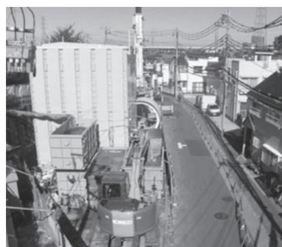
写真一 11 騒音対策実施状況（防音ハウス，極低騒音型バックホウ）
