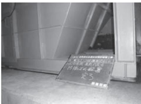
写真一 9 防振ゴムシート設置状況
