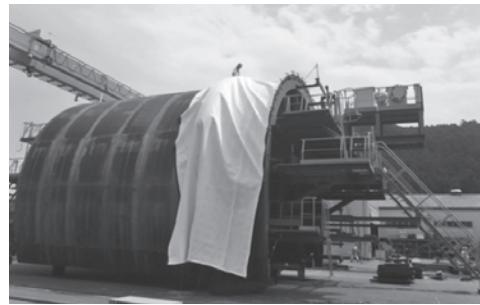
写真一4 バルーンによる押し上げ時の状況
